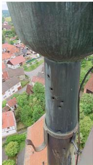
Und noch eines: im Kirchturm in Höchheim wurden bei der Reparatur der Sturmschäden Einschusslöcher gefunden. Den Kirchturm als Zielscheibe zu benutzen, bei denen Einschusslöcher in Größe von 1 cm entstehen, ist kein Lausbubenstreich.
